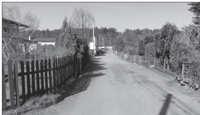
Alejki mogą doczekać się właściwego utwardzenia dopiero po wykonaniu inwestycji wymagających wykopów.
